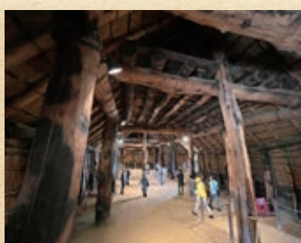
▲ 大型竪穴建物の内部、住居の他に集会場や共同作業場などの説があります。
