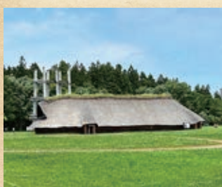
▲ 三内丸山遺跡では大型竪穴(たてあな)建物と大型掘立柱建物が復元されています。
