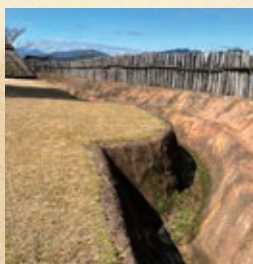
▲ 南内郭の防御施設 堀の中の敵を横から攻撃出来る突出部。
