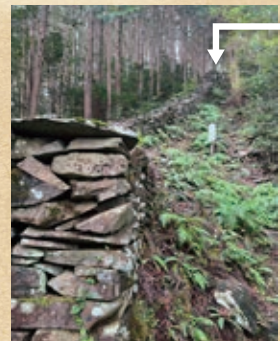
東之台から本丸まで続く最も長大な石 塁。扁平な鉄平石状の石材を用いた石塁 は20カ所、700mにおよんでいる。
