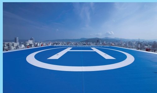
▲ A棟13階 屋上ヘリポート
